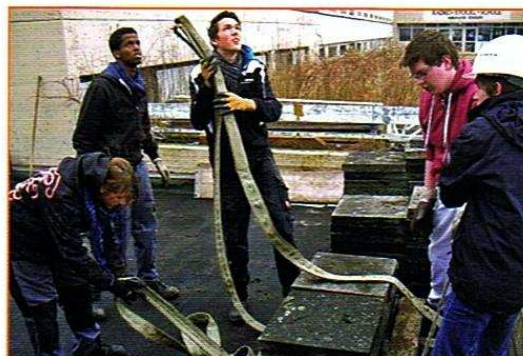
Pflasterarbeiten am Technikhaus der Radko-Stöckl-Schule
