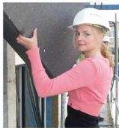
Auszubildende bei der Montage eines Dämmstoffblocks für das Technikhaus
